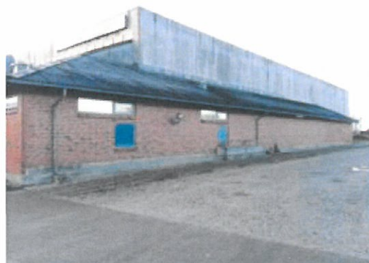
Vinduer og lemme i sidebygning mod nord
