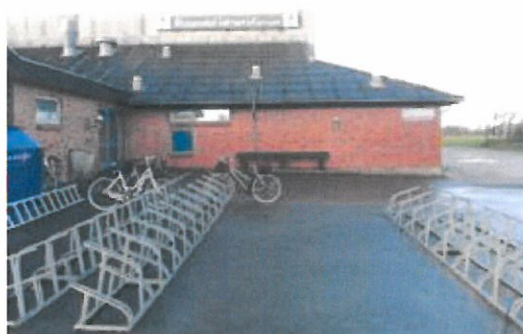
Vinduer og lem i sidebygning mod øst
