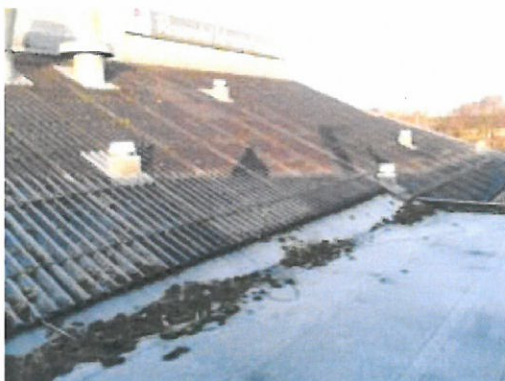
Tagdækning på sidebygning mod fladt tag
