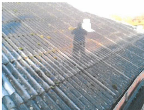
Tagdækning på sidebygning mod fladt tag
