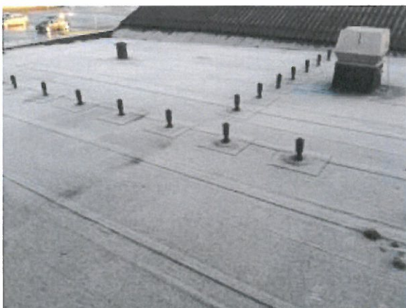
Tagpapdækning på mellembygning
