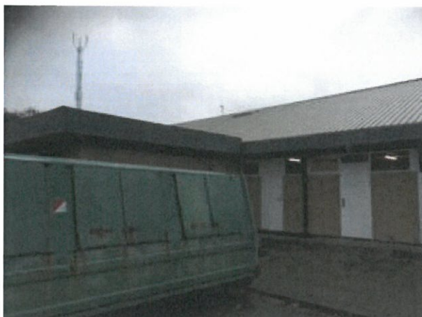
Døre og vinduer i den ældre del af sidebygning mod øst
