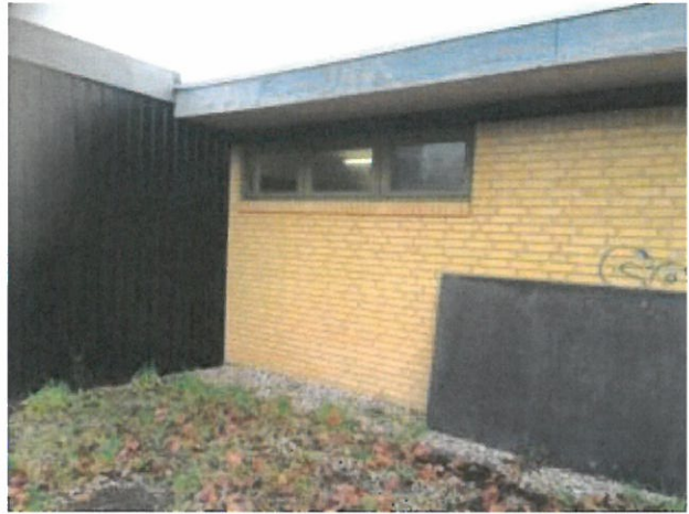
Vindue til boldrum
