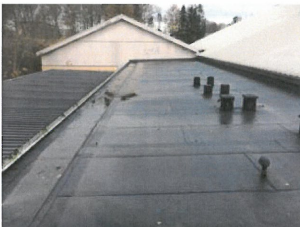
Tagpapdækning på sidebygning mod vest
