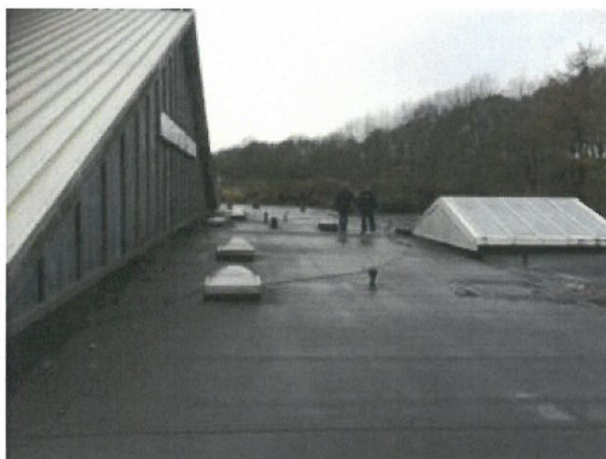
Tagpapdækning på sidebygning mod nord
