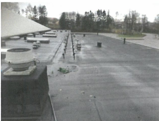
Tagpapdækning på sidebygninger mod øst
