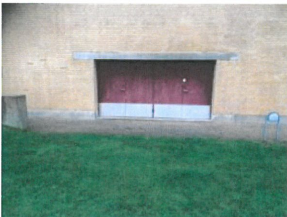
Flugtvejsdør i gavl mod syd
