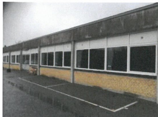
Vinduer mod vest i sidebygning til hal 1
