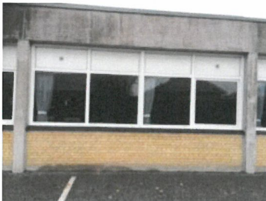
Vinduer mod vest i sidebygning til hal 1
