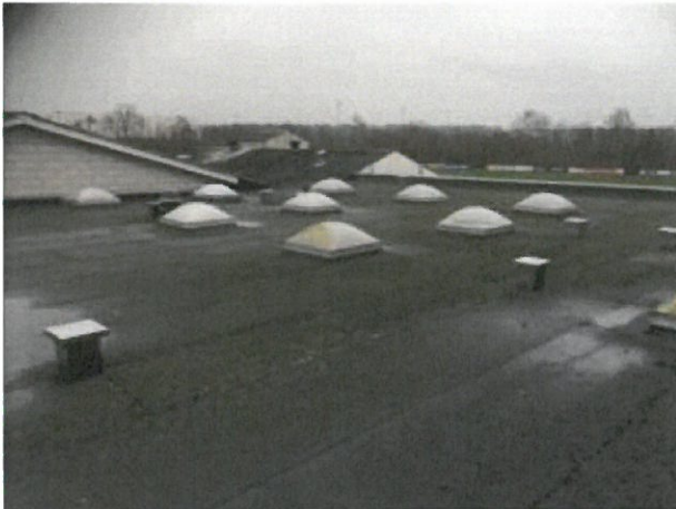
Fladt tag over omklædningsbygning
