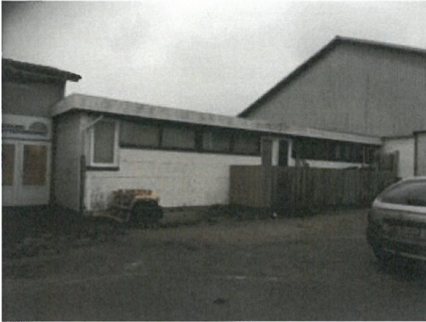
Facade på omklædningsbygning
