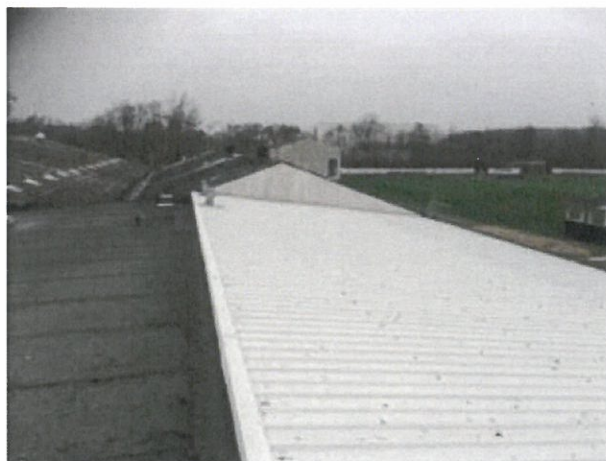
Stålpladetag over cafeteria
