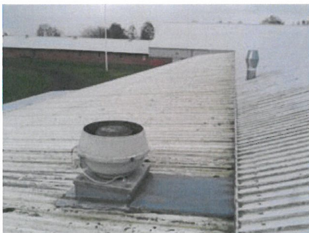
Stålpladetag over cafeteria
