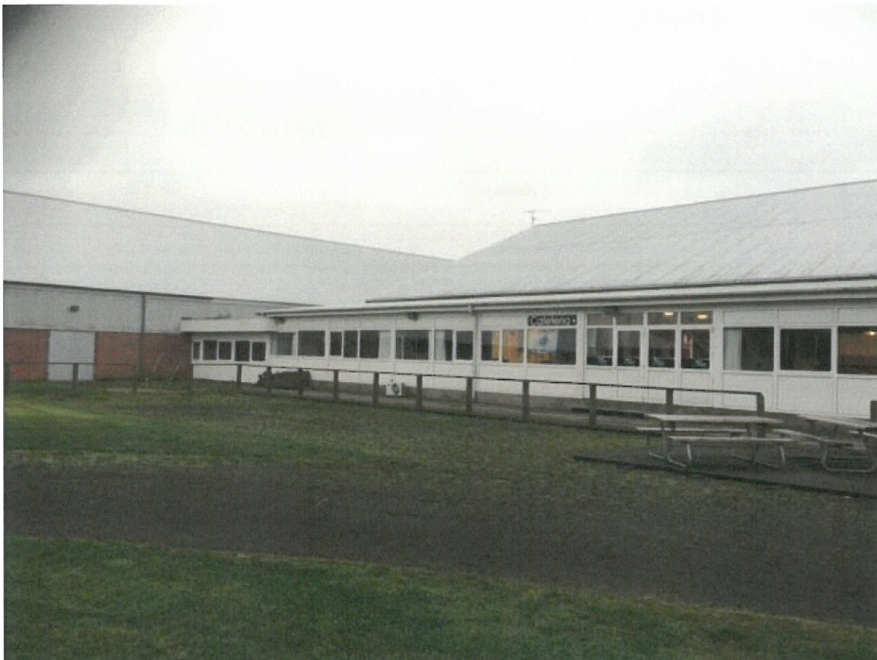
Facade på mellembygning ses længst til venstre mod hal B
