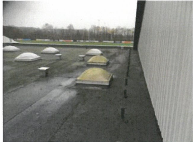
Fladt tag over omklædningsbygning
