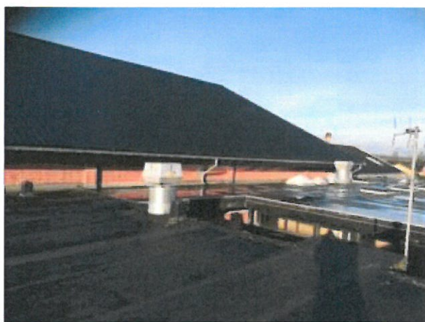
Fladt tag med tagpapdækning og nedsænket tagflade
