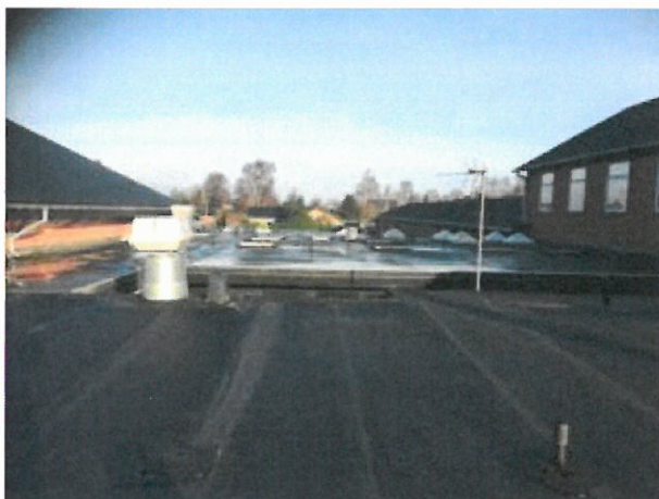
Fladt tag med tagpapdækning og nedsænket tagflade
